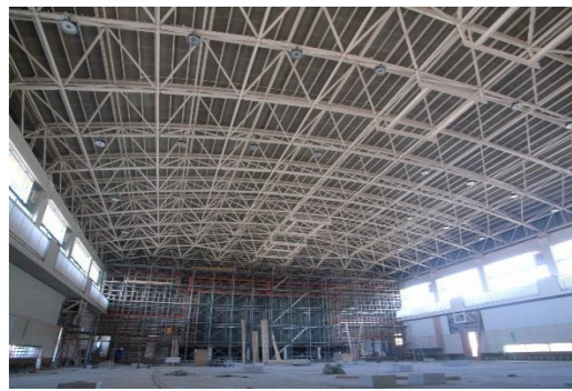
中学校 トラス・屋根下地工事
