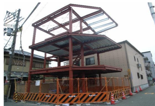
大阪市 個人宅新築工事 約30t
