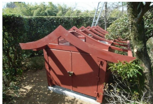
個人宅 神具新設工事
