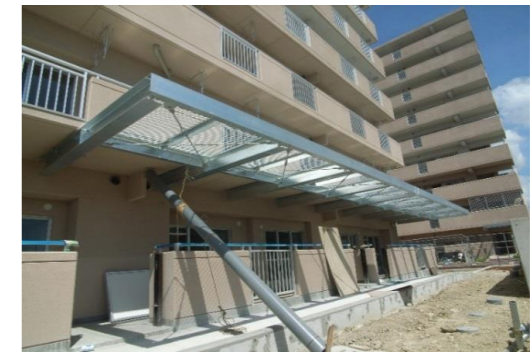
集合住宅 防護柵新設工事
