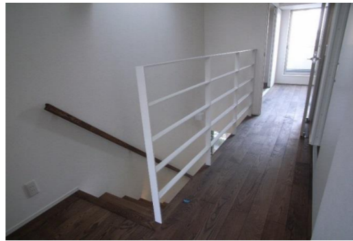
個人宅 屋内手摺工事
