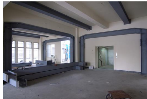
東大阪市 工場RC耐震改修工事
