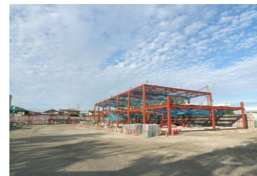
大津市 事務所新築工事 約90t
