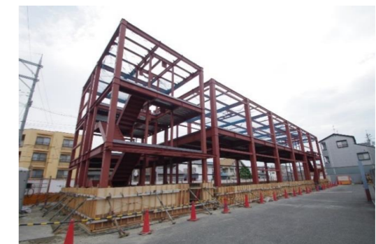
東大阪市 工場・社屋新築工事 約80t
