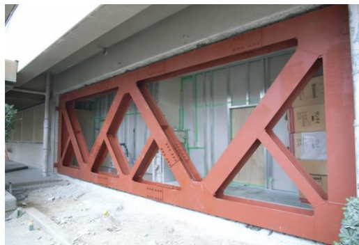
大阪市 中学校耐震改修工事
