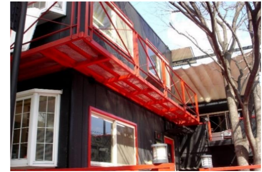
バルコニー床・手摺増設工事
