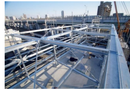
集合住宅上部 屋外看板新設工事
