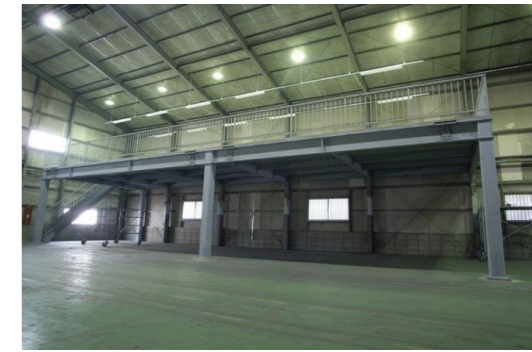
工場内 中二階増設工事
