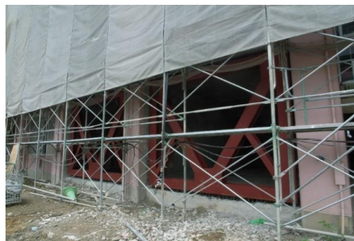
八尾市 小学校耐震改修工事
