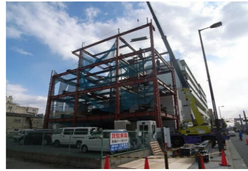
大阪市 事務所新築工事 約60t
