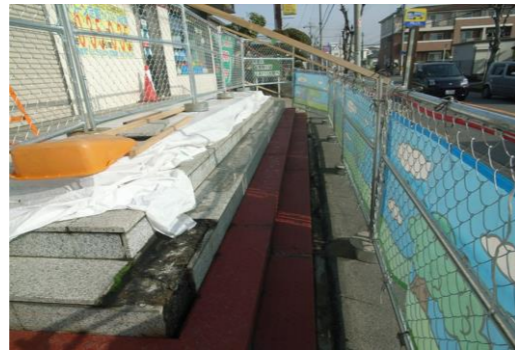
店舗 階段補修工事
