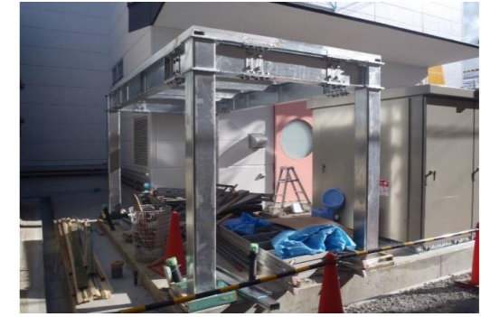
キュービクル架台工事
