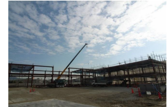
八尾市 教習所新築工事 約180t
