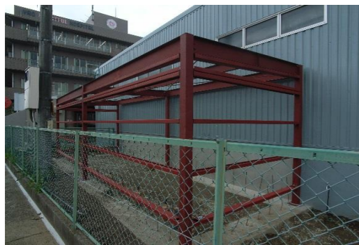
工場 休憩所増築工事
