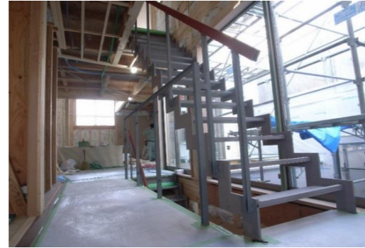
ストリップ階段工事
