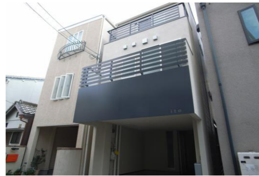
個人宅 正面ファサード金物新設工事
