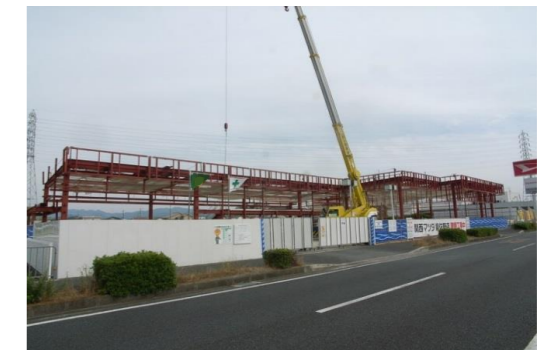
泉佐野市 車販売店新築工事 約80t
