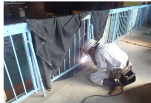
小学校 手摺補修工事
