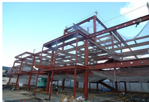
東大阪市 老人介護施設新築工事 約120t
