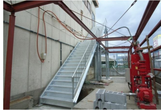
避難階段 取り替え工事
