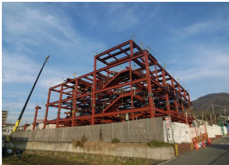
東大阪市 保育園新築工事 約160t
