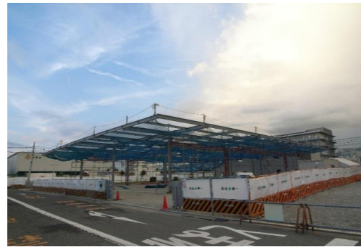
東大阪市 物流施設新築工事 約60t
