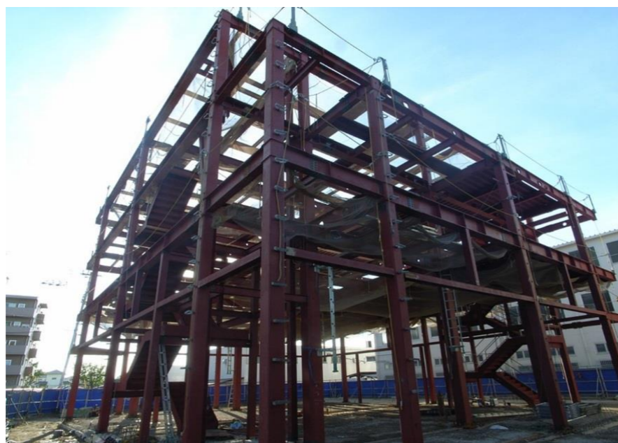
大阪狭山市 工場新築工事 約180t
