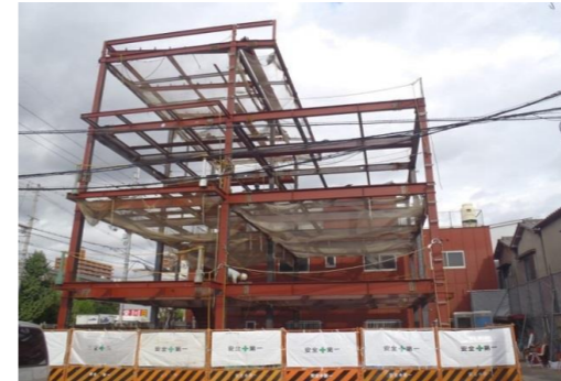
東大阪市 老人介護施設新築工事 約60t
