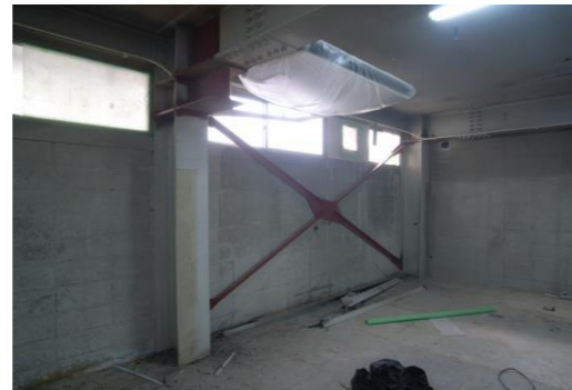
八尾市 工場耐震改修工事
