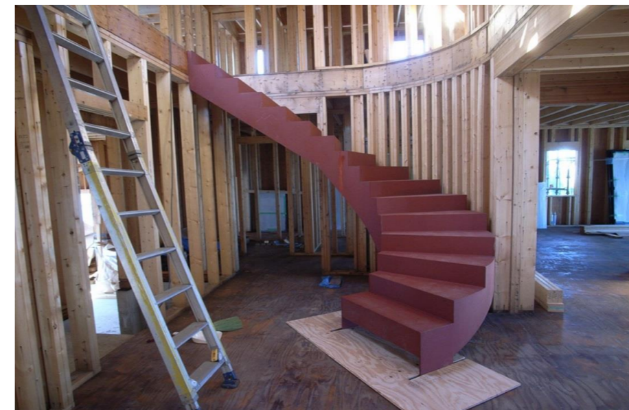
室内 らせん階段取り付け工事
