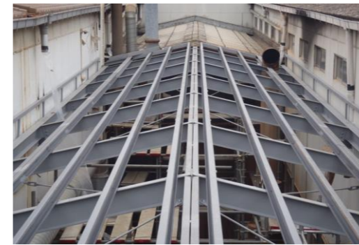
工場棟間 屋根新設工事
