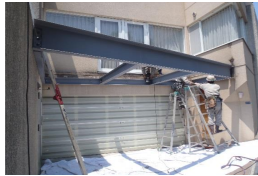
個人宅 ガレージ上部床増設工事
