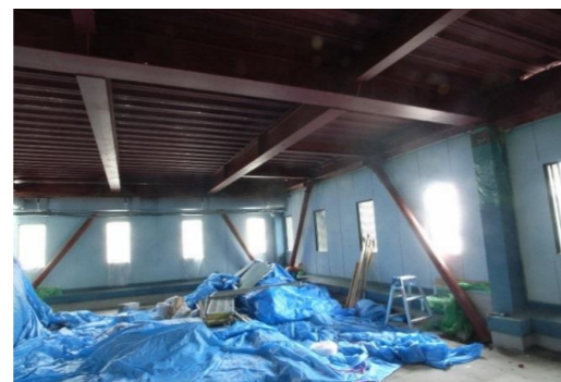
東大阪市 工場増床・耐震改修工事
