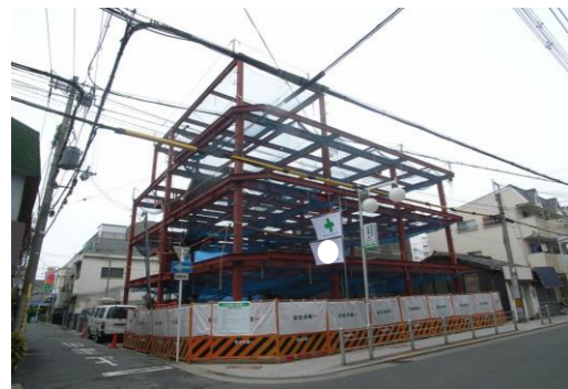
大阪市 事務所新築工事 約60t
