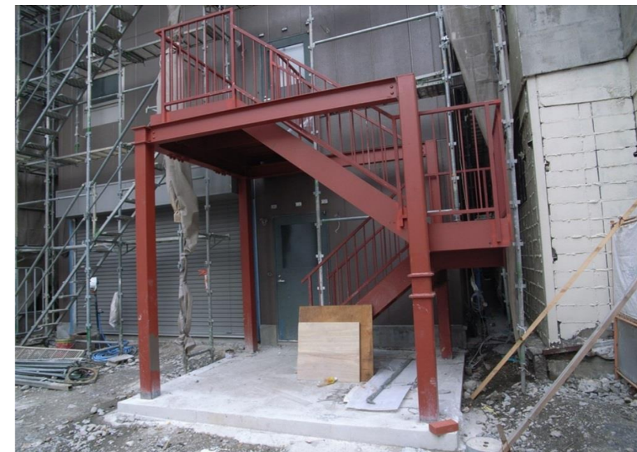
屋上避難階段増築工事
