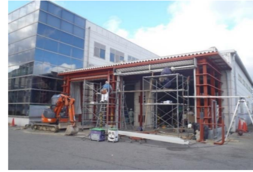
工場シャッター新設工事
