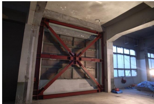
東大阪市 工場耐震改修工事
