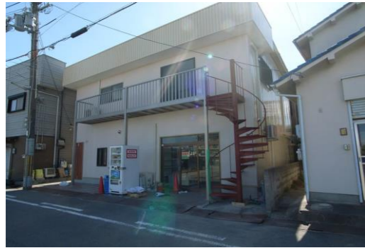
らせん階段新設工事
