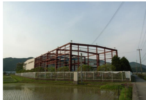
京都府綾部市 工場新築工事 約90t
