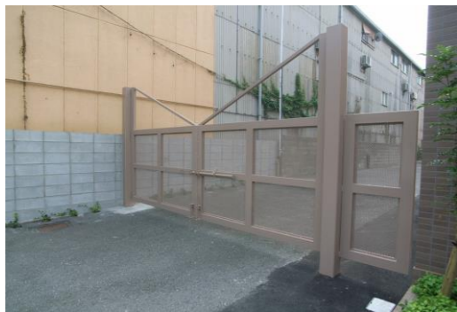
工場 門扉新設工事
