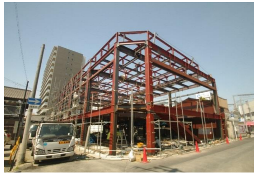
東大阪市 遊技場新築工事 約135t
