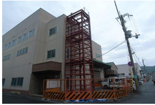
EVシャフト 増設工事
