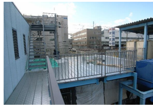
工場 床増設工事
