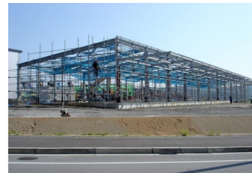
三田市 物流倉庫新築工事 約80t
